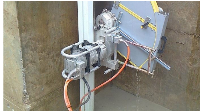
Betonsägemaschine / Concrete saw
