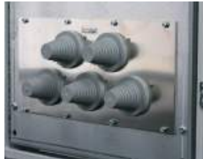
Kaapeleiden läpivienti erotusseinän läpi TS 8 kaapissa moduulilevyjä hyödyntäen.
