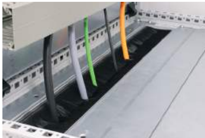
KDRS edut: ahtaissa kohteissa kaapeleiden veto läpivienniltä suoraan johtokouruun
