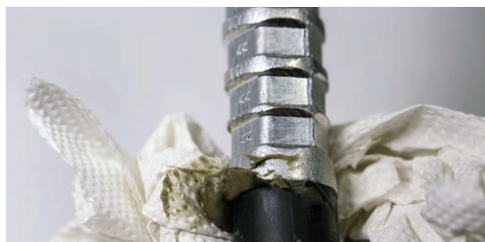
Kuva 8: 1. Poista eriste, 2. Puhdista johdin, 3. Aseta johdin, 4. Purista (tässä kuusiopuristus), 5. Pyyhi kontaktirasva pois
